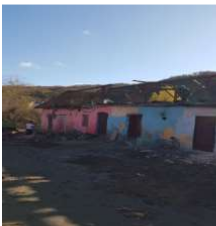
Str. Angărul de Jos, nr. 53, înainte de reparații:
