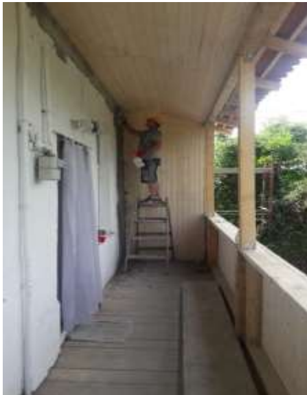
Str. L. Blaga, nr. 32, după reparații:
