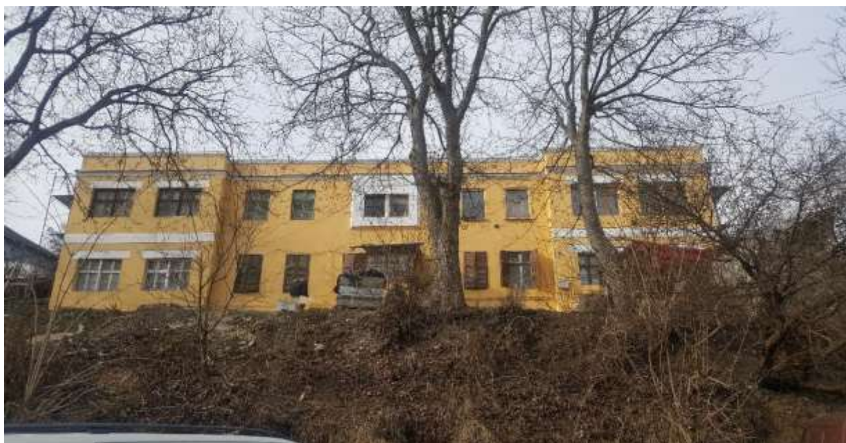
Ceahlau nr.10 reparații
