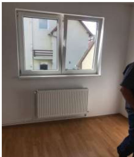
Castanilor nr. 1 după intervenții de reparații
